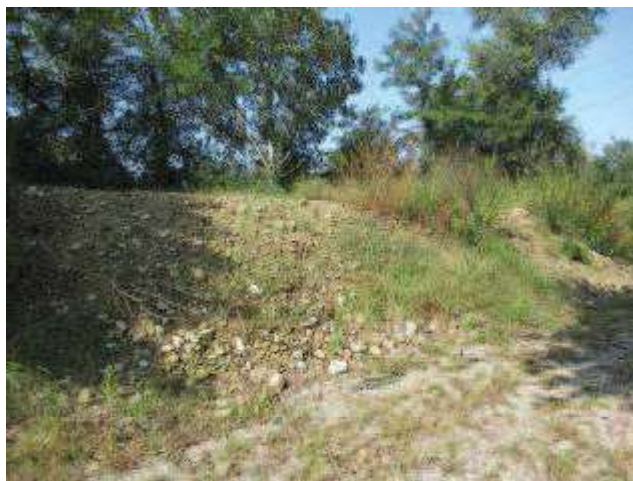
Foto 7-9. Tratto dell'opera all'altezza di Pratoregio. La vegetazione sul terrazzo di scarpata è uniformemente di tipo ripariale e arbustivo. Il sedimento è sabbioso e le opere spondali di difesa sono costituite da ciottoli misti a ghiaia.
